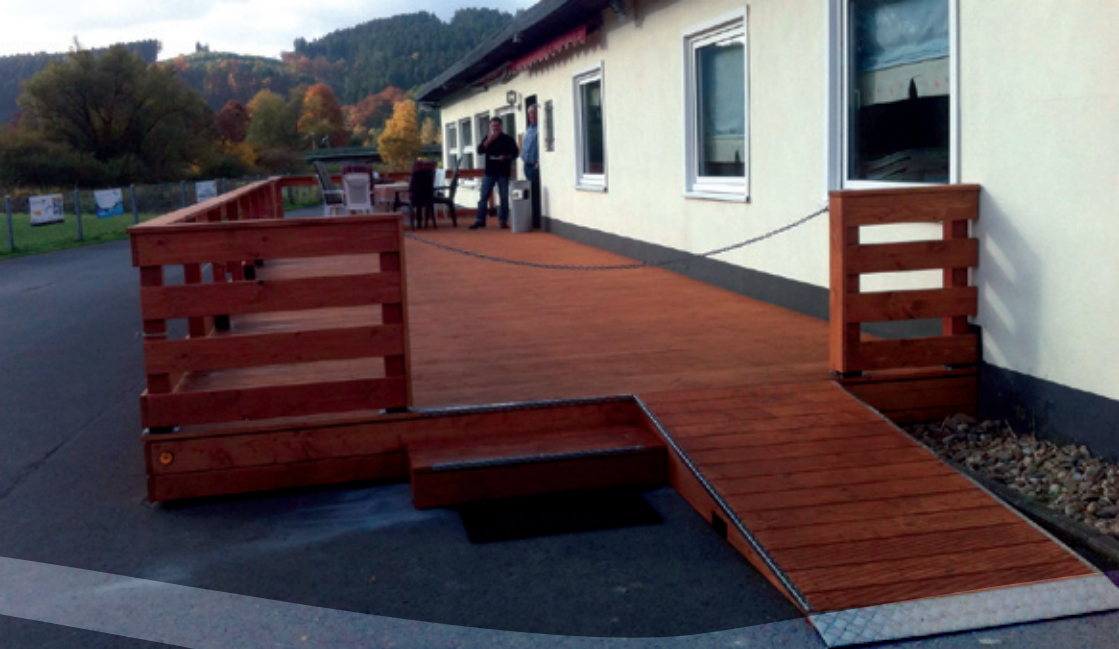
Die fertige Terrasse vor dem Spatzennest.
